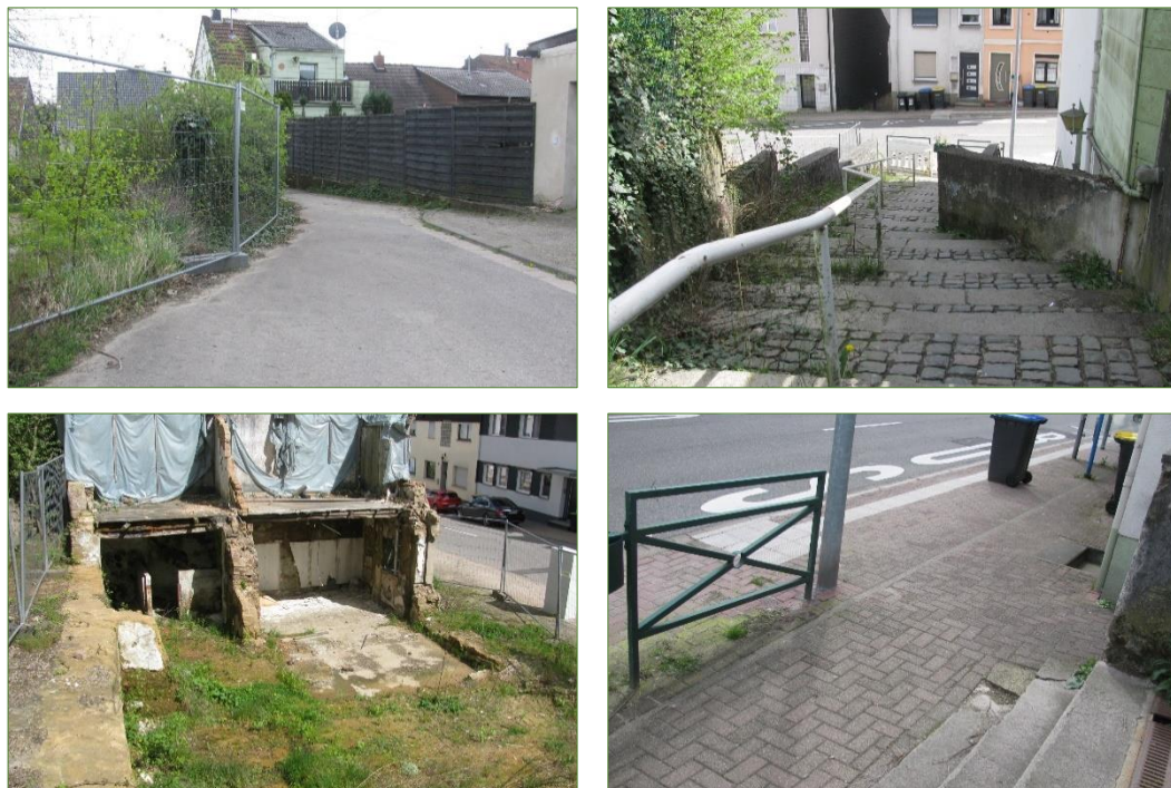
Abbildung 3 - 6: Straßenraum der Bethelstraße (oben links), Treppe des Fußweges zur Hauptstraße (oben rechts), Gebäudeabriss (unten links) und Gehweg im Bereich der Hauptstraße) (ARGUS CONCEPT)
