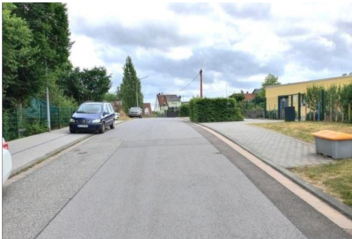
Bethelstraße, Blick vom Kindergarten (rechts) in Richtung Hauptstraße – © Ingenieurgruppe Kohns Plan GmbH
